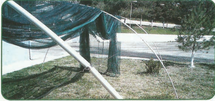
Topraksız Mikroseranın Alüminyum İskeletinin Üzerine %40'lık Gölgeleğin Yerleştirilmesi
