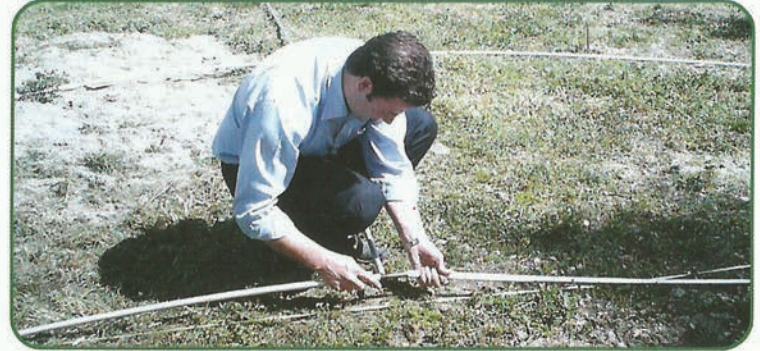
Topraksız Mikroseranın Alüminyum İskelet Parçalarının Birleştirilmesi-1
