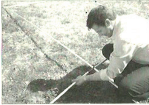
Topraksız Mikroseranın Alüminyum iskelet parçalarının Birleştirilmesi
