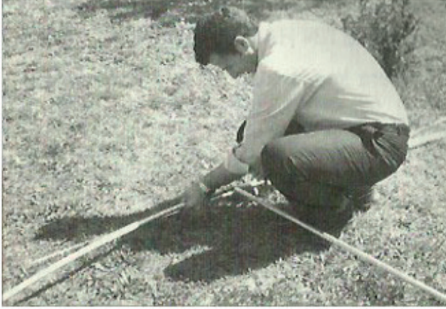
Topraksız Mikroseranın Alüminyum iskelet parçalarının Birleştirilmesi
