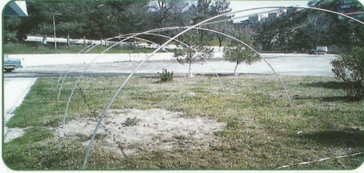
Topraksız Mikroseranın Alüminyum İskeletinin Kurulmuş Durumu
