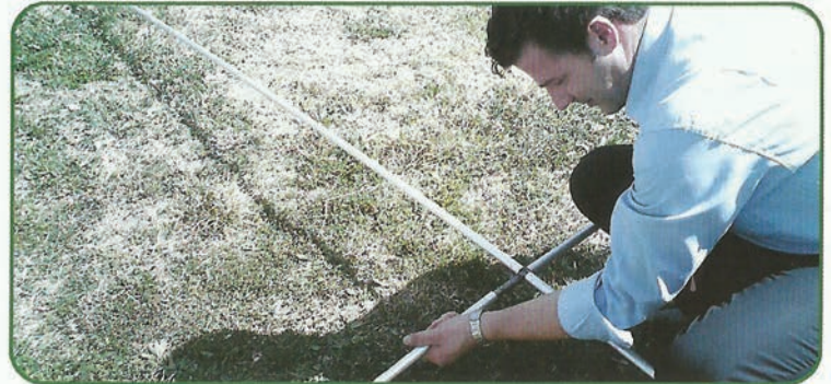
Topraksız Mikroseranın Alüminyum İskelet Parçalarının Birleştirilmesi-2
